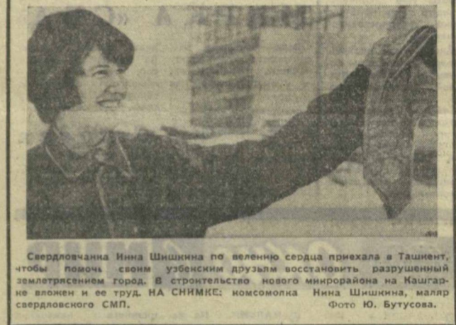
Свердловчанка Инна Шишкина по велению сердца приехала в Ташкент, чтобы помочь своим узбекским друзьям восстановить разрушенный землетрясением город. В строительстве нового микрорайона на Кашгарке вложены и ее труд. НА СНИМКАХ: комсомолка Инна Шишкина, маляр свердловского СМП. Фото Ю. Бутусова.
