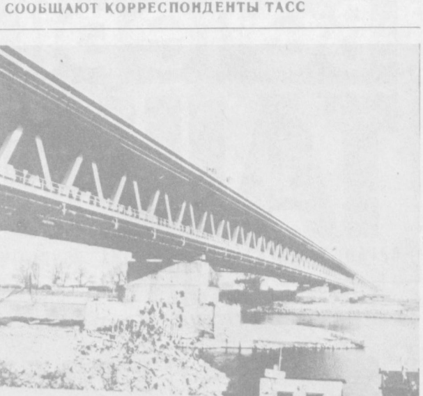
СССР. На два года раньше запланированного срока сдан в эксплуатацию новый мост через Дунай (на снимке). По его первому ярусу пошли электропровода, а верхний предназначен для автотранспорта, велосипедистов и пешеходов.
