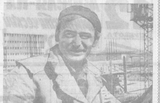
ТАШКЕНТ. Отлично несут ленинскую трудовую вахту молодые строители стройтреста № 11 «Высотстрой», возводящие здание Института искусственного имени Хамзы. НА СНИМКЕ: один из лучших элентростроителей — Виктор Мартыненко. Его ежедневный производственный показатель — полторы нормы. Фото Н. Ключева. (УзТАП).
