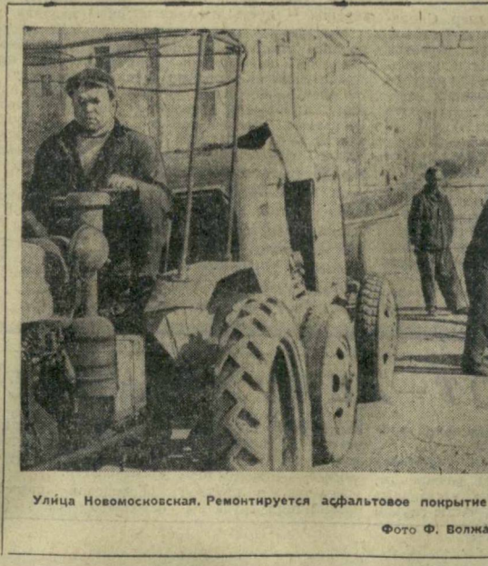
Улица Новомосковская. Ремонтируется асфальтовое покрытие дорог.
