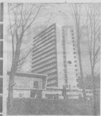
Всесезонный курорт Сочи пополнился еще одной здравницей. Завершено строительство санаторного комплекса «Анжер».
