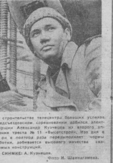
На строительстве телецентра больших успехов в предвзвешенном соревновании добился электромонтажник Александр Кузнецов из второго управления треста № 11 «Восстановление». Это дня в день он в полтора раза перепроизводит нормы выработки, добиваясь высокого качества свариваемых конструкций.
