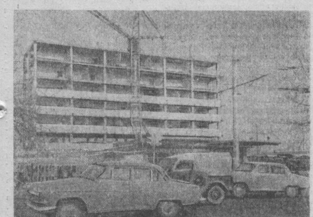
НА СНИМКЕ: новое административное здание гражданского воздушного флота по улице Пролетарской. Возводит его строители треста «Мгострой-11».
