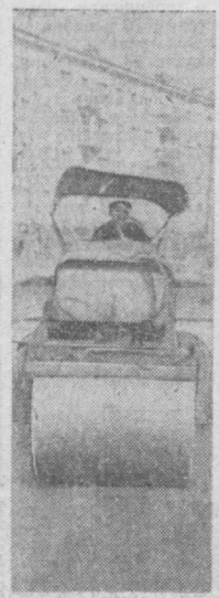
Асфальтирование улицы Новоомосовской производит бригада, возглавляемая А. Кузнецким (РСУ-3 треста «Гордорстройремонт»).
