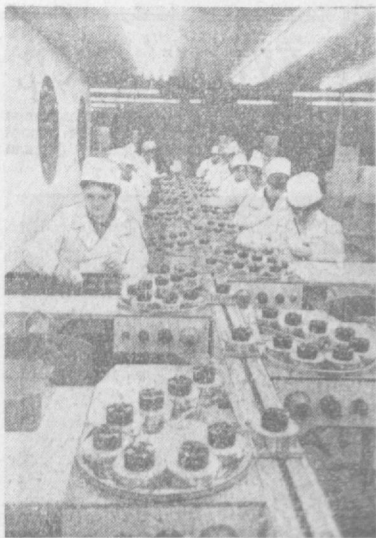
МОСКВА. В ПАРКЕ КУЛЬТУРЫ И ОТДЫХА «СОКОЛЬНИКИ» ОТКРЫ- лась международная выставка «АВТОМАТИ- ЗАЦИЯ-60». НА СНИМКЕ: В ПА- вильоне СССР ПОТОЧ- но-конвейерная МЕ- ханизованная ли- ния с АВТОМАТИЧЕ- ским АДРЕСОВАНИЕМ ДЛИ СВЯЗКИ УЗЛОВ ФИТОВ. Фото В. Кузьмина. (Фотокроника ТАСС).
