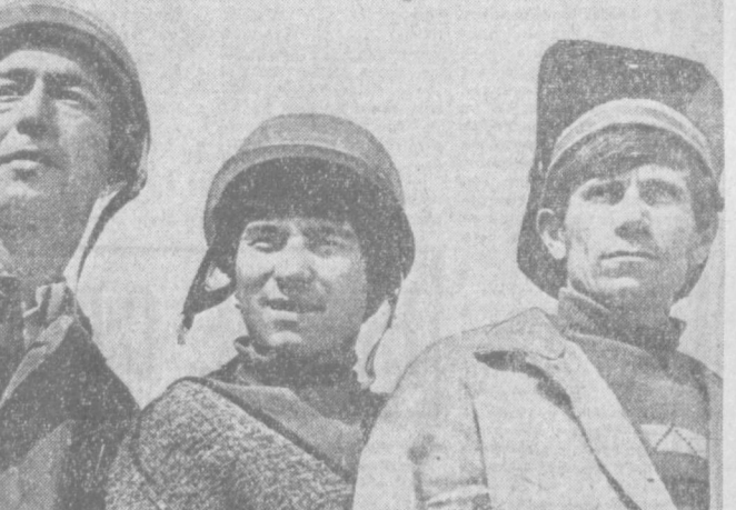
Соревнуясь за достойную встречу первомайского праздника, коллектив комплексной бригады строительного управления № 14 треста № 153, который руководит В. Христофуду, неизменно добивается трудовых успехов, перевыполняя сменные задания. Сейчас бригада возводит здание проектного института «Гидропроброкт» по улице Фархадской. Коллектив трудится под девизом: строить быстро, при высоком качестве работ. В бригаде немало передовых строителей, на которых держит равнение коллектив. Среди них монтажник Туйсун Шаумаров, каменщик Инам Юнусов, сварщик Шавкат Фатеев, которых вы видите на снимке. Фото И. Шанигамова.
