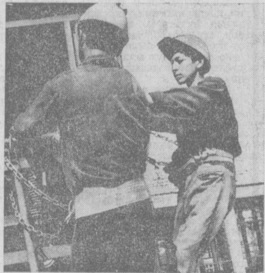
Пройдет совсем немного времени и Ш. Умаров, А. Тулганов (на снимке), окончив профессионально-техническое училище № 63, станут монтажниками и войдут в ряды строителей. Опыт у них уже есть. Оба выпускника участвуют в строительстве нового здания телецентра. Фото М. Гадульшина.
