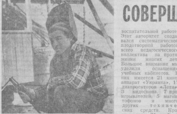
Михаил Ушаков из ГПТУ-63 приобрел специальность сварщика. Во время производственной практики он участвовал в строительстве домов на Карамикме.
