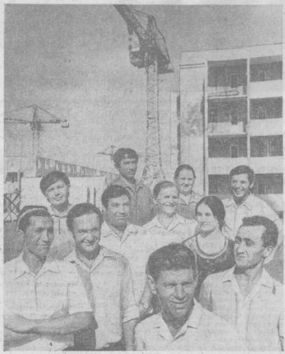
Высокими трудовыми показателями встретил свои праздники коллектив комбинской бригады Ю. Чумака (монтажное управление № 1, ДСК-1). В эти дни строители трудятся в счет декабря 1975 года. Фото И. Глауберсона и В. Сиротина.
