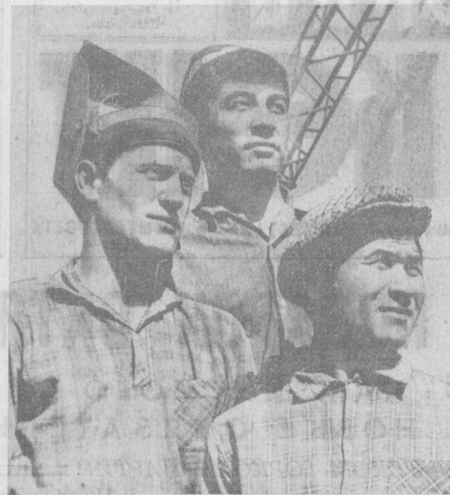
Отлично трудится на сооружении 72-квартирного дома в квартале ЦИ «Б» бригада, возглавляемая Стернесом Андоину из СУ-8 треста № 159.
