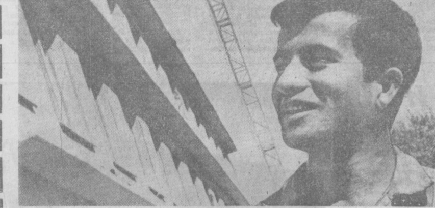
СУ-53 треста № 159 готовит и сдает в эксплуатацию административное здание «Союзгазпрома» по улице Маллосова. Хорошо трудился на объекте инженер Кадир Ташмухамедов. Ежедневно выполнял норму не ниже чем на 115 процентов.
