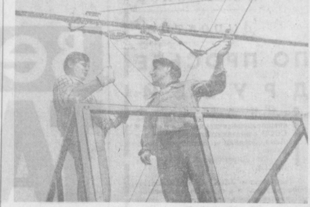
Ремонтно-строительное управление Ташкентского трамвайно-троллейбусного треста реконструирует маршрут № 6. Скоро по этому маршруту пойдут новые трамвайные поезда. Фото М. Нуритдинова.
