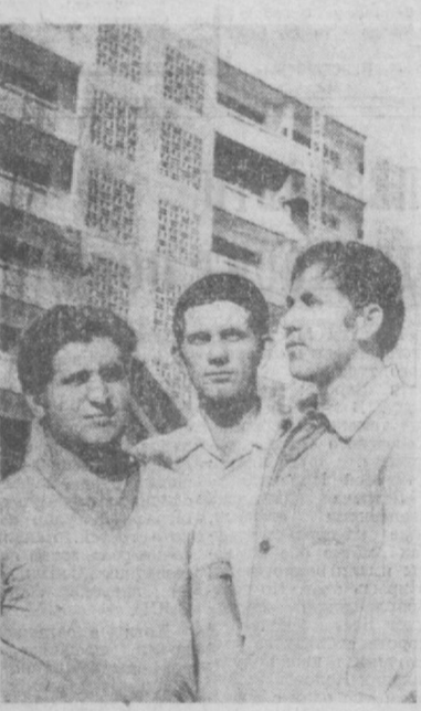
Бригада М. Турнина из первого монтажного управления треста «Ташкентгазмонтаж» закончила прокладку теплотрассы в квартале Т-11. Теперь в новом доме № 4 жильцы могут пользоваться всеми удобствами. НА СНИМКЕ: слева направо — переводчик рабочие управления В. Дмитриев, И. Вавичук и Л. Булантин. Фото И. Шангамазова.
