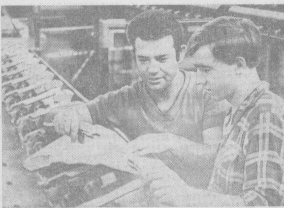
В Ташкентском филиале специального конструкторского бюро по текстильному машиностроению получают путевку в жизнь первые образцы новых текстильных машин. НА СНИМКЕ: лучшие слесари-сборщики Борис Шапиро и Николай Соколов за сборкой новой ровничной машины «Р-260-4-2».
