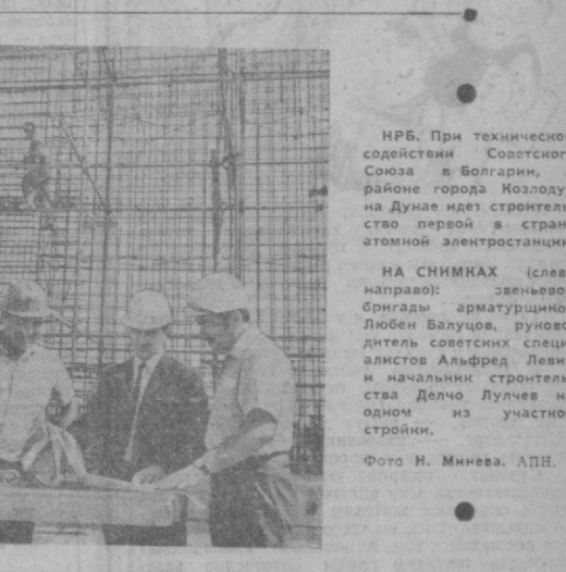
НРБ. При техническом содействии Советского Союза в Болгарии, в районе города Козлодуй на Дунае идет строительство первой в стране атомной электростанции.
