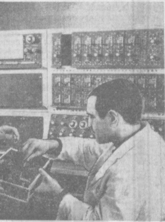
СОФИЯ. Группа конструкторов из научно-исследовательского и проектно-конструкторского института приборостроения создала малогабаритную электронно-вычислительную машину, собранную на полупроводниковых приборах «Аналог-3».
