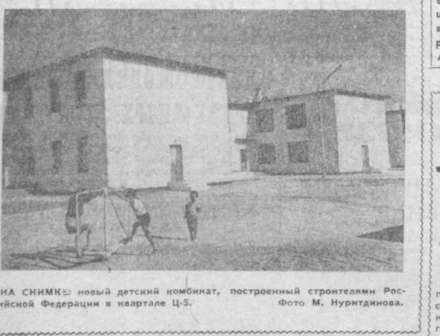
НА СНИМКЕ: новый детский комбинат, построенный строителями Российской Федерации в квартале Ц-5. Фото М. Нуритдинова.
