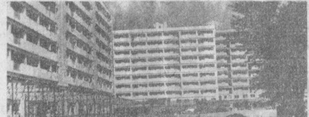
Спешат, торопятся посланцы Башкирии завершить благоустроительные работы возле дома-гиганта. НА СНИМКЕ: башкирский 9-этажный гигант. Фото М. Нуритдинова.
