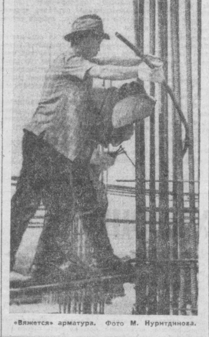
«Вяжутся» арматура. Фото М. Нуритдинова.
