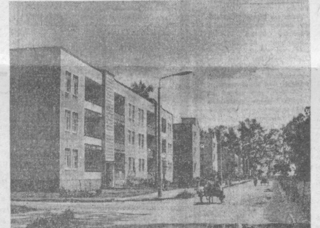
ЗАНЗИБАР. Новостройки в столице одноименного острова. На месте африканского предместья Занзибара-Нгамо с помощью ГДР сейчас строятся новые 3-4-этажные дома. Фото С. КУЛИКА.
