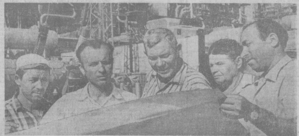
НА СНИМКЕ: группа ветеранов треста «Узбеггидроэнергострой» (слева направо) — бригадир отделочников А. Мосенд, начальник участка И. Рудик, бригадир С. Глухов, бетонщица К. Куликова, начальник участка М. Барз. Все они с первых дней работают на строительстве ТашГЭС, являются передовиками производства. Фото И. Глауберсона и В. Сироткина.
