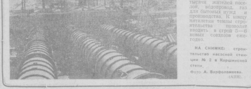
НА СНИМКЕ: строительство насосной станции № 2 в Каршинской степи. Фото А. Варфоломеева. (АФВ)
