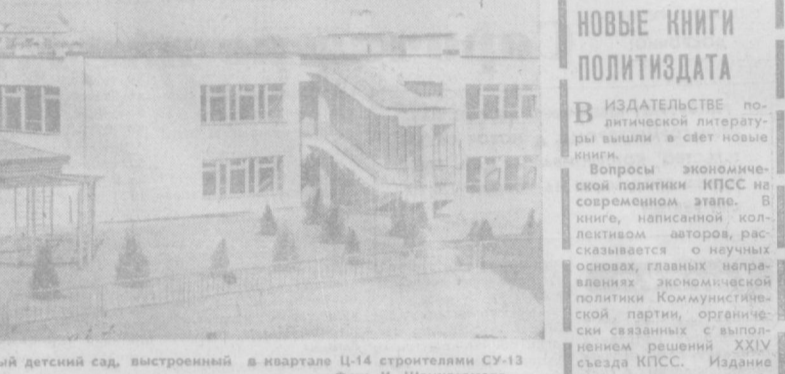
НА СНИМКЕ: вы видите новый детский сад, выстроенный в квартале Ц-14 строителями СУ-13 треста № 159. Фото И. Шанагамова.
