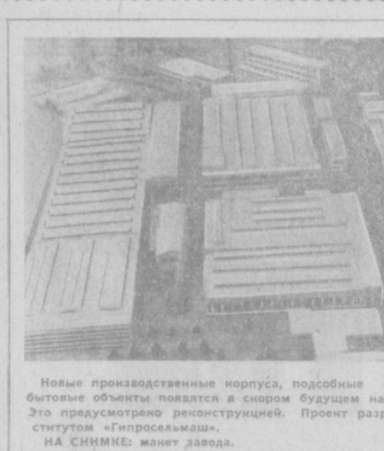
Новые производственные корпуса, подсобные помещения, культурно-бытовые объекты появятся в скором будущем на заводе «Ташсельмаш». Это предусмотрено реконструкцией. Проект разработан проектным институтом «Ташсельмаш». НА СНИМКЕ: маневр завода. Фото М. Нуритдинова.
