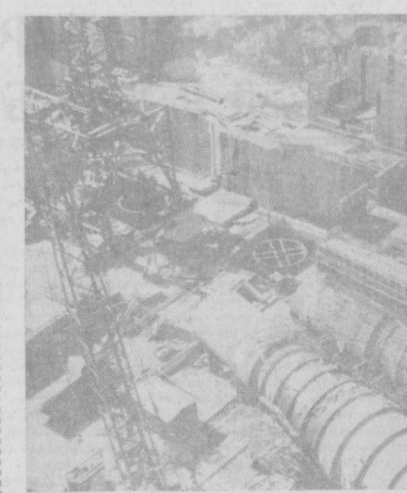
НА СТРОИТЕЛЬСТВЕ ТОКТОГУЛСКОЙ ГЭС.
