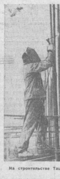
На строительстве Ташкента. Фото М. Нуритдинова.
