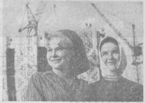
Людмила Еремينا и Татьяна Мостова трудятся на строительстве филиала Музея В. И. Ленина. Выполненная ими работа всегда отличного качества. Своим примером опытные маляры увлекают остальных членов бригады. НА СНИМКЕ: Л. Еремина и Т. Мостова на строительстве монументального комплекса. Фото В. Бысова.
