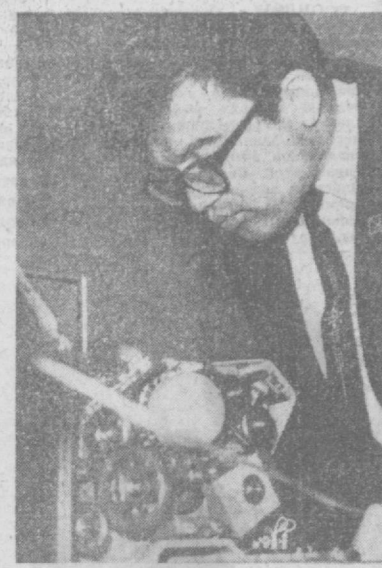
В информационном вычислительном центре Госплана УзССР. На снимке: старший инженер Камилджан Фазылов проверяет работу аппарата «МП-16» электронно-вычислительной машины «Минск-22».
