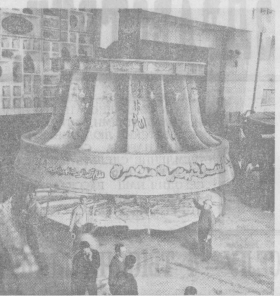
ОБЪЕДИНЕННАЯ АРАБСКАЯ РЕСПУБЛИКА. Заканчиваются основные работы по сооружению Асуанского гидроэнергетического комплекса, который строится с технической помощью Советского Союза. Недавно на Асуанской ГЭС начался монтаж последней 12-й гидротурбины. Все 12 гидротурбин по 178 тысяч киловатт каждая были изготовлены на Ленинградском металлургическом заводе имени XXII съезда КПСС. НА СНИМКЕ: монтажные работы на 12-м гидроагрегате. Фото А. Горячева.
