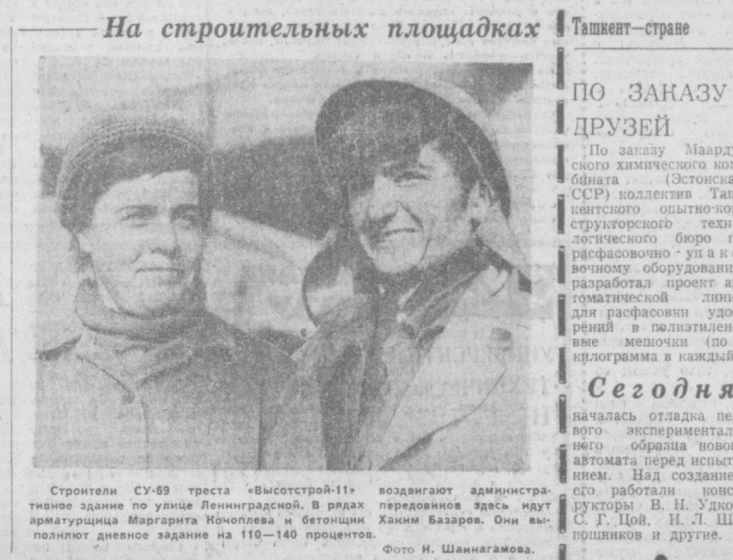
Строители СУ-69 треста «Высотстрой-11» воздвигают административное здание по улице Ленинградской. В руках арматурщица Маргарита Кюбоглова и бетончик Владимир Базаров. Они выполнят дневное задание на 110-140 процентов.
