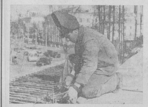
Строится Музей искусств. НА СНИМКЕ: сварщик А. Сабиров (СУ-39 треста № 6). Дневную норму он выполнит на 130—140 процентов. Фото В. Исакова.
