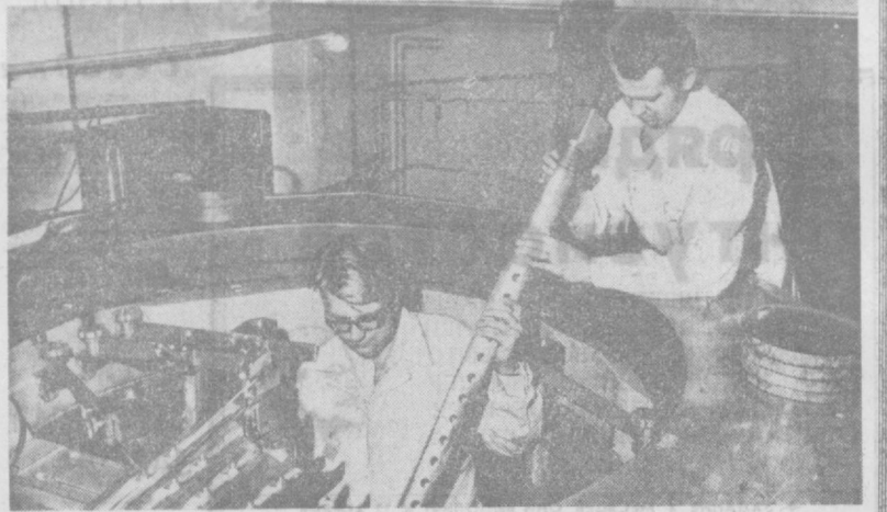
ЧЕХОСЛОВАКИЯ. На одном из заводов машиностроительного объединения «Шкода» имени В. И. Ленина в Пльзене заканчивается сооружение первого отечественного ядерного реактора, предназначенного для научных изысканий — в частности для изучения проблемы защиты от радиации. НА СНИМКЕ: монтаж реактора. Фото ЧТК — ТАСС.
