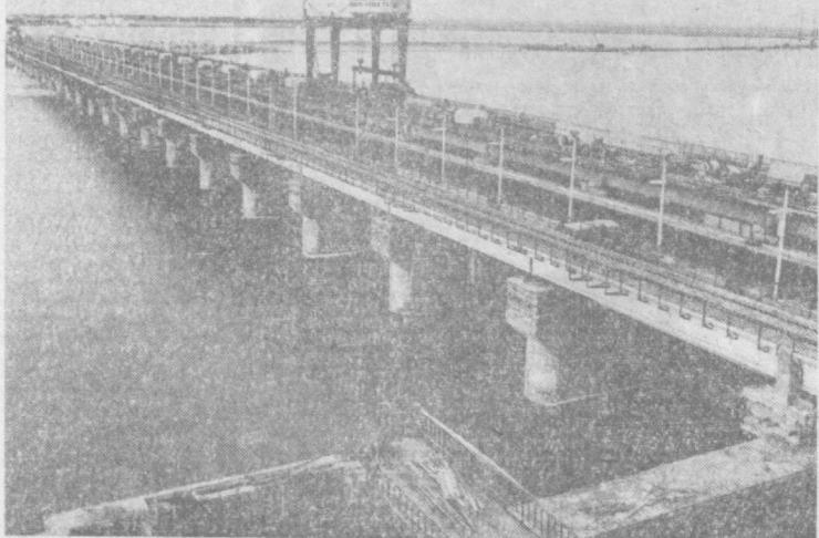
ПО УЗБЕКИСТАНУ. Одной из крупнейших строен девятой пятилетки является сооружение Ташхатского гидроузла на Амударье. НА СНИМКЕ: вид на гидроузле. Фото Л. Гусейнова.
