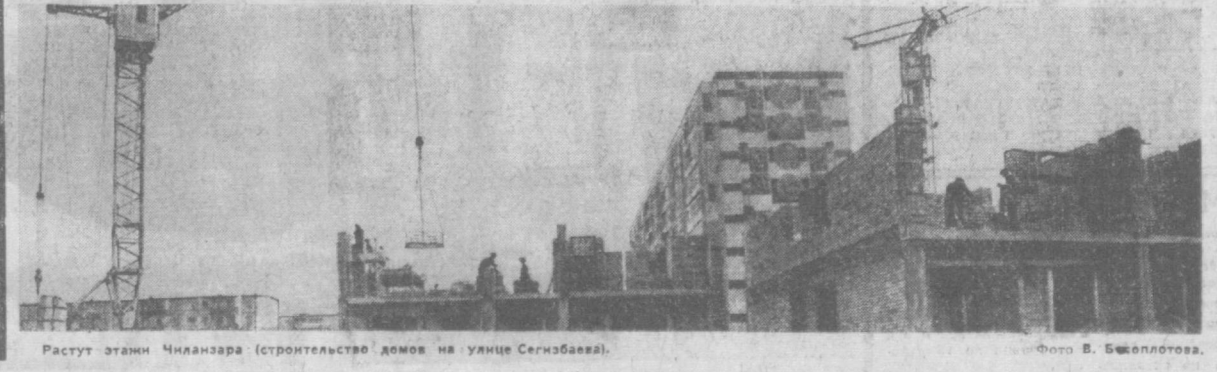
Растут этажи Чиланзара (строительство домов на улице Сегизбаба). Фото В. Бешеллотов.
