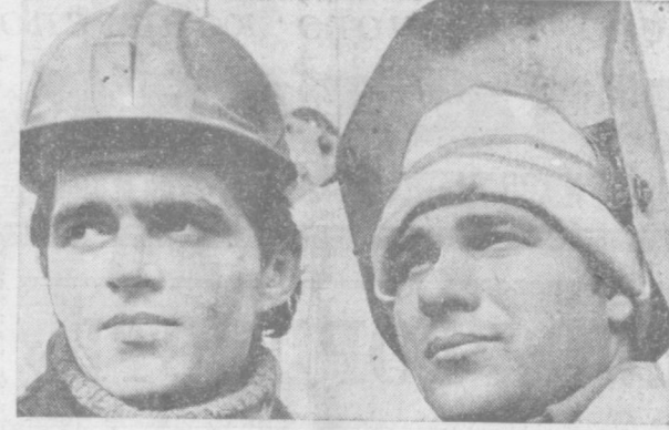
Комплексная бригада Г. Шумилина — одна из лучших в строительном управлении № 13 треста № 159. Претворяя в жизнь взятые на себя обязательства по достойной встрече XXV съезда КПСС, этот дружный коллектив добился высокой выработки. Дневные задания здесь выполняются на 160—170 процентов. НА СНИМКЕ: передовые строители бригады В. Сапета и В. Ивашенко. Фото И. Шанигомова.
