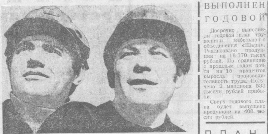
Комплексная бригада, возглавляемая Героем Социалистического Труда Хамидом Карабаевым (СУ-17 треста № 11 «Высотстрой»), возводит административное здание на Луначарском шоссе. Здесь особенно по-ударному трудятся зявевый Иргаш Хабидуллаев и плотник Тахир Лутфуллин (на снимке).
