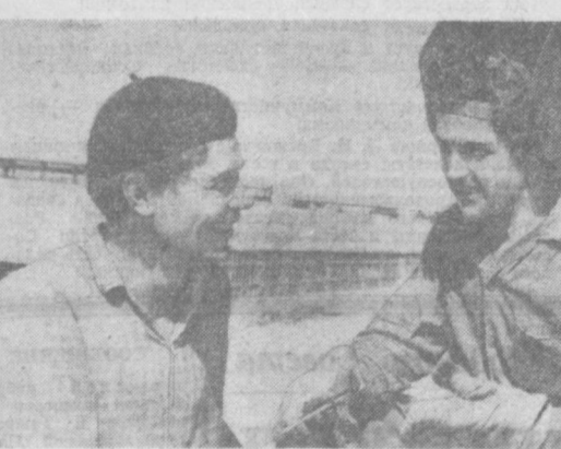
Мебельный комбинат, который вступит в строй в конце года, будет крупнейшим в республике. А пока строительство в полном разгаре. НА СНИМКЕ: передовые сварщики Владимир Горячев (слева) и Григорий Манаров. Фото Р. Альбенова.
