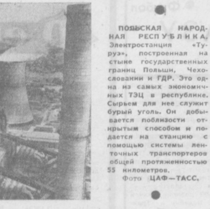
ПОЛЬСКАЯ НАРОДНАЯ РЕСПУБЛИКА. Электростанция «Турзу», построенная на стыке государственных границ Польши, Чехословакии и ГДР. Это одна из самых экономичных ТЭЦ в республике. Сырьем для нее служит бурый уголь. Он добывается близостью открытым способом и подается на станцию с помощью системы ленточных транспортеров общей протяженностью 55 километров. Фото ЦАФ-ТАСС.
