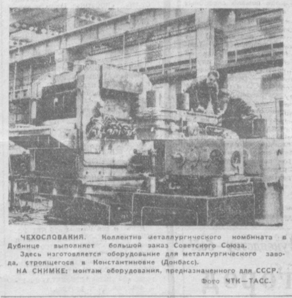
ЧЕХОСЛОВАКИЯ. Коллектив металлургического комбината в Дубнице выполняет большой заказ Советского Союза. Здесь изготавливается оборудование для металлургического завода, строящегося в Константиновке (Донбасс). НА СНИМКЕ: монтаж оборудования, предназначенного для СССР. Фото ЧТН-ТАСС.
