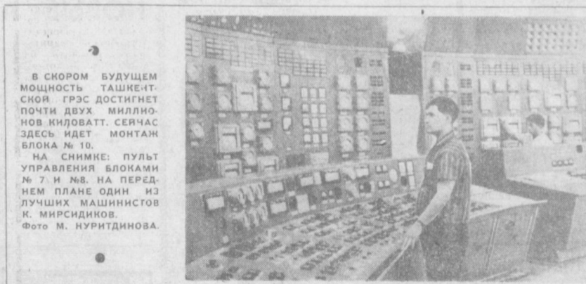
В СПОРОМ ВУЩЕМ МОЩНОСТЬ ТАШКЕНТ-ГРЭС ДОСТИГНЕТ ПОЧТИ ДВУХ МИЛЛИОНОВ КИЛОВАТТ. СЕЙЧАС ЗДЕСЬ ИДЕТ МОНТАЖ БЛОКА № 10. НА СНИМКЕ: пульт управления блоками № 7 и № 8. НА ПЕРЕДНЕМ ПЛАНЕ ОДИН ИЗ ЛУЧШИХ МАШИНИСТОВ К. МИРСИДИКОВ. Фото М. НУРИДИНОВА.
