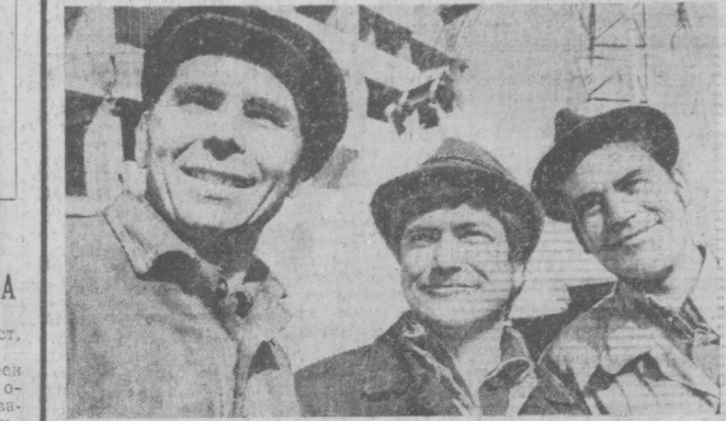
Коллектив семадзатого управления стройтреста № 11 «Высострой» возводит новое здание Ташкентского почтамта. В СНИИМЕ (слева направо): лучшие рабочие строики ударники, коммунистического труда, экаваторщик Марс Нигматуллин и В.И.К. тор Андрей, бульдозерист Леонид Андреев. Фото М. Нуритдинова.
