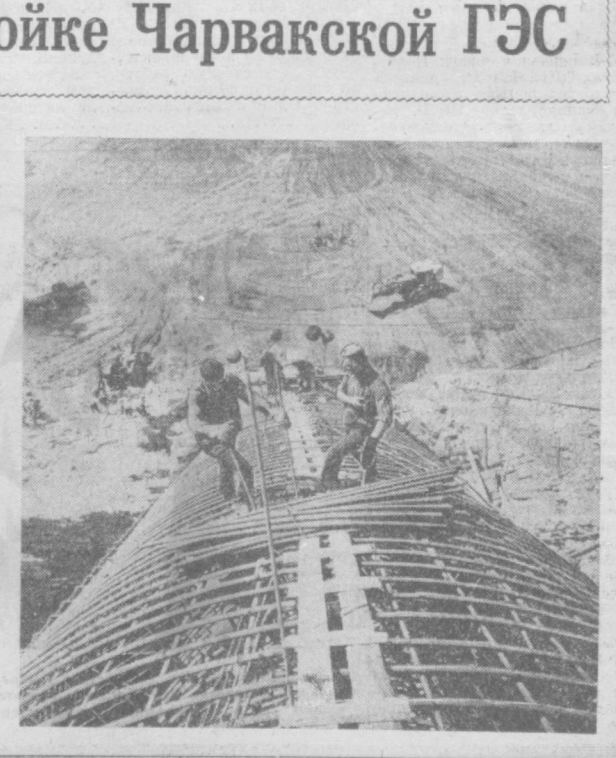
НА СНИМКЕ: строительная площадка Чарвакской ГЭС. По этим трубам будет подаваться цемент для укладки в тело плотины. Фото В. Чернова. (АПН).
