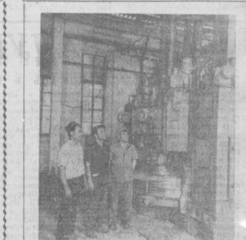
Новый агрегат абразивной комбината по выпуску абразивных изделий скоро начнет выпускать продукцию на экспорт. НА СНИМКЕ: наладку и монтаж оборудования ведут инженер-конструктор А. Артынов, слесари М. Абдурахманов и С. Сидиков.
