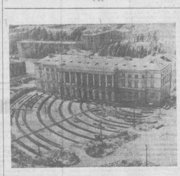
Интересная техническая операция осуществлялась в Варшаве. Исторический Люблинский дворец, построенный два столетия назад, передан на новое место. Теперь он обращен фасадом и популярному парку жителей центра — Сасни парк. По отношению к освещению 10.000-тонное здание было повернуто на 78 градусов. Сложную задачу выполняли танкеры и толкавшие его 16 гидравлических кранов. Дворец, установленный на 1.600 «матюгах», передвигался по стальным рельсам (сильный длинный — 78,4 метра) со скоростью 1 сантиметр в минуту. Дневная «пуля» составляла около 2 метров. НА СНИМКЕ: здание дворца перед «возвращением». Фото ЦАФ—ТАСС.
