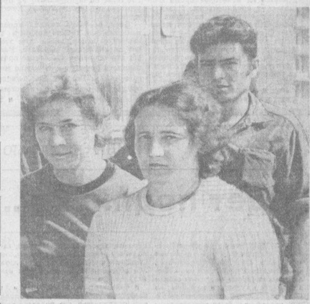
На этом снимке — трое из большого отряда строителей жилого массива Куйлюк. Бетонщица М. Исханова, М. Павла и монтажник В. Осмиров — члены комсомольской бригады СУ-57 треста № 3, которую возглавляет Г. Брагиня. На 3-м квартале массива они воздвигли жилой дом, который принят государственной комиссией с оценкой «хорошо».
