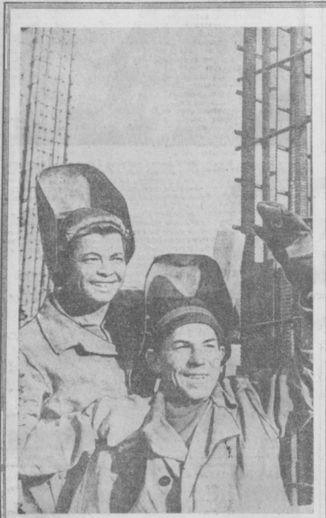
Комплекс СУ-14 стройтреста № 153 возводит Дом кино по улице Чиланзарской. Хорошо трудится на строительстве комплексная бригада Шамакура Шаюмова.
