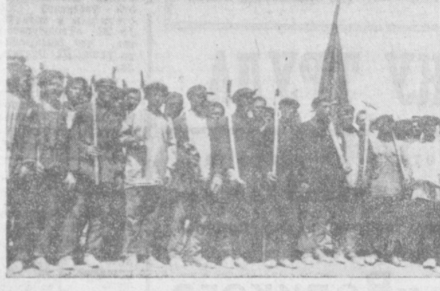
Ударная бригада строителей текстильного комбината в т. а. 1932 года.
