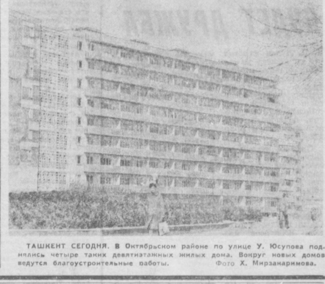
ТАШКЕНТ СЕГОДНЯ. В Октябрьском районе по улице У. Юсупова поднимается четыре этажных девятиэтажных жилых дома. Вокруг новых домов ведутся благоустроительные работы. Фото Х. Мирзааримова.
